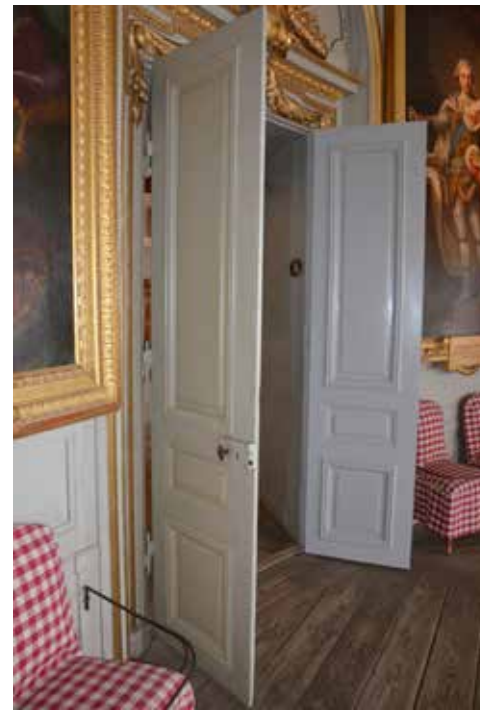
Dörrar på Gripsholms Slott brandskyddsmålade med HW01
