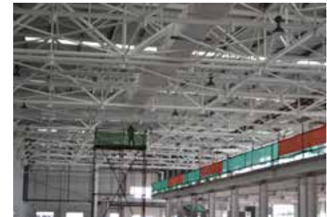
Fackverkstak i metall. Allt stål skyddat enligt brandkonsulentens specifikation med CON-RFB HS
