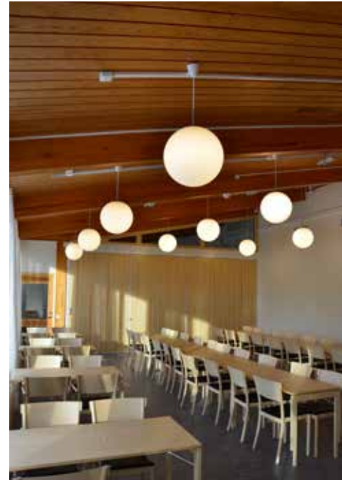
Bollmora kyrka. Trätak behandlat med ES/VFR flamskyddslack till B-s1,d0
