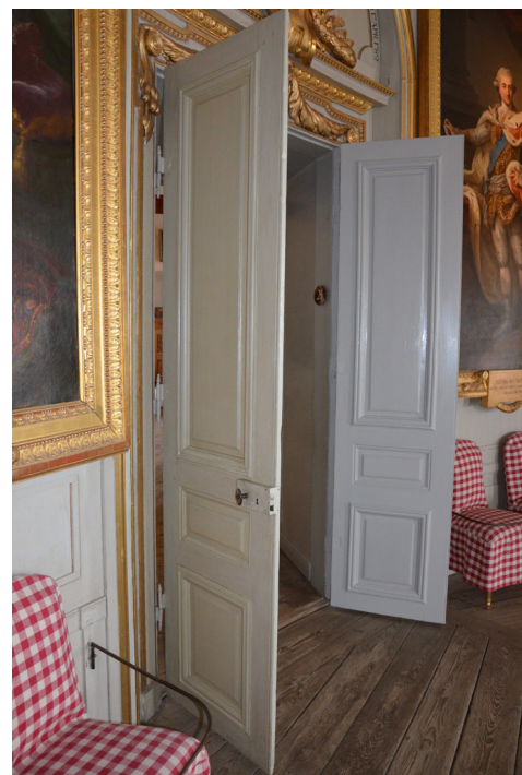
Dörrar på Gripsholms Slott brandskyddsmålade med HW01
